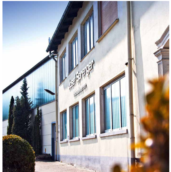
Seit Januar 2012 versorgt ein Dachs die Josef Sprenger GmbH und das benachbarte Wohnhaus mit Strom und Wärme. Noch im selben Jahr erhielt das mittelständische Unternehmen den RWE Klimaschutzpreis.
